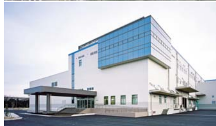
上) 南部市場全景 下) 南部市場外観
