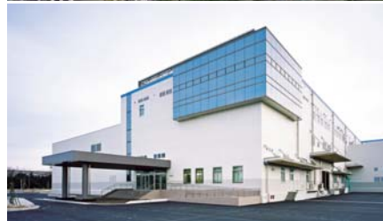
上) 南部市場全景 下) 南部市場外観
