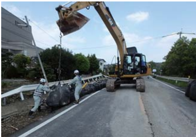
震災直後の復旧工事現場
