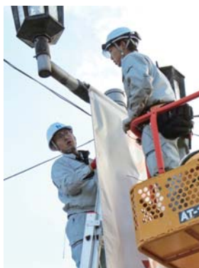
電気工事現場
