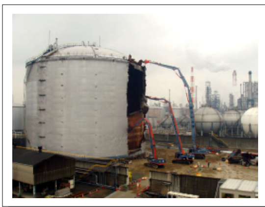
▶ T150タンク更地化工事 新日本石油株式会社 水島製油所
