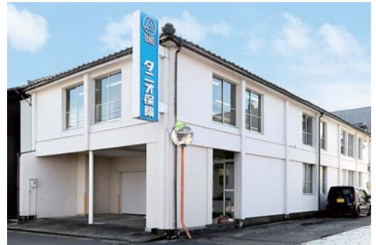
武生事務所 (福井県越前市: 大正時代に建築)
