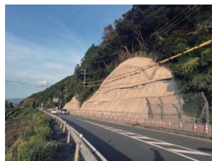
道路維持工事現場
