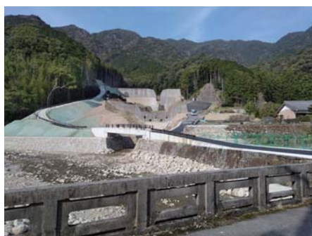
砂防工事現場
