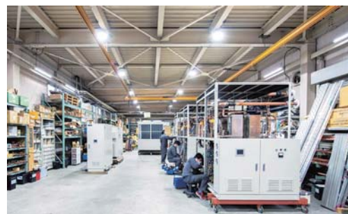
本社工場・サービスセンター内部（愛知県名古屋市）
