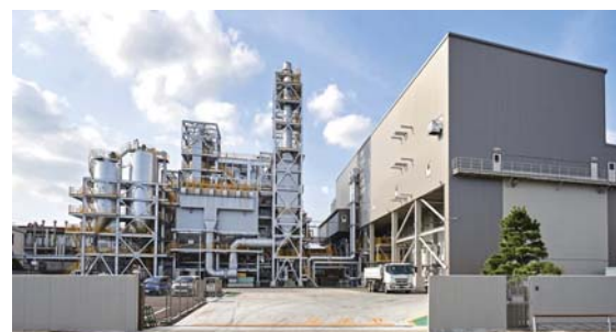
伏見環境保全センター 高効率熱回収施設 (新3号焼却炉：京都市伏見区)
