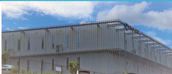
本社社屋 (京都市西京区)
