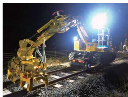
八頭タイタンパーでの作業風景
