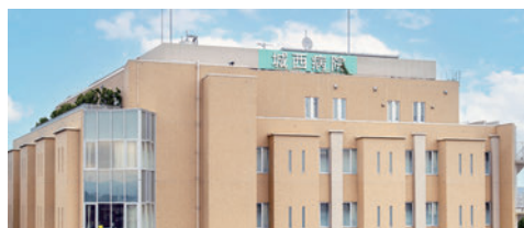
病院外観（東京都杉並区）
