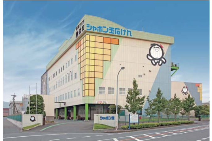
本社工場（福岡県北九州市）
